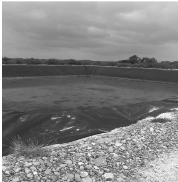
Foto. Pozo de fracking , en el municipio de los Ramones Nuevo León 4 de abril de 2016
