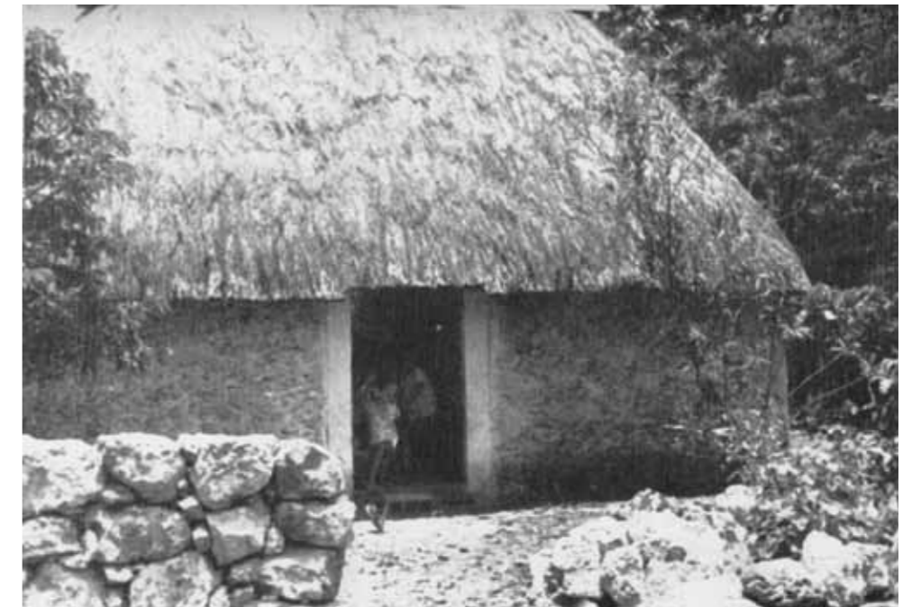
29). Esta nueva casa se compone de paredes de mampostería y techo de zacate. Se espera que más adelante, cuando los recursos de la familia lo permitan, la casa será ampliada y mejorada. En la entrada una niña de 6 años cuida del hermano menor. (Littlefield, 1972).
