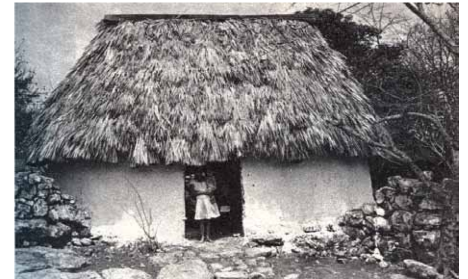
3).- Casa reparada o recién construida, (foto Carlos Kirk, 1970).
