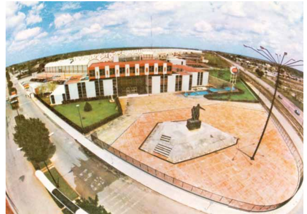
76. Vista general de frente del complejo cordelero Cordermex (1977).
