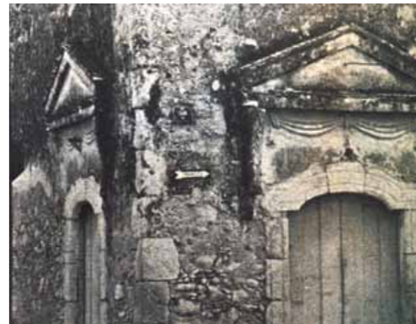
47).- Pórticos y esquina de una casa colonial en Mérida. 1948.
