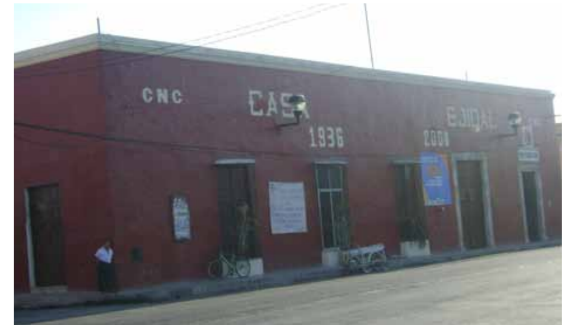
81).- Casa ejidal del Ejido de Baca construida en 1936. Hasta en la actualidad es uno de los edificios más importante de la población, (foto Esteban Villanueva Pérez, 2009).
