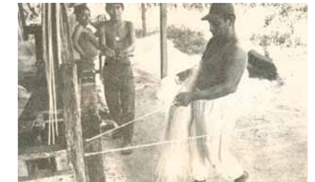
10).- Fabricación de cordeles de henequén con una hiladora de madera, (foto Carlos Kirk, 1970).
